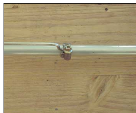
Bild 8: Übergang der Phasenleitung zum Aluminiumrohr mittels Schlauchschelle
