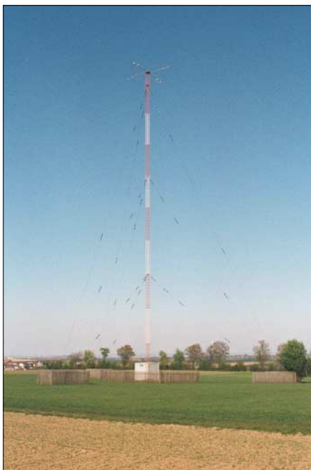
Sendemast in Hirschlanden, Zustand im Frühling 2002 nach Inbetriebnahme der Megaradio-Frequenz 738 kHz Foto: Autor
